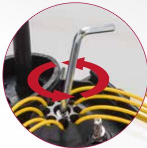
**7.2** Inserte los kits de sellado del puerto redondo mecánico en el puerto de cierre redondo, fíjelos con una llave Allen
